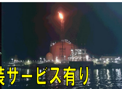
エネオスLNGターミナル
